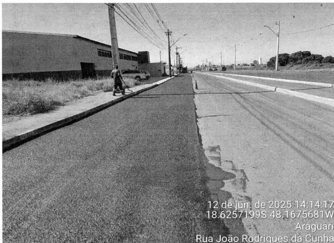
Foto 1: Execução de Microrrevestimento
